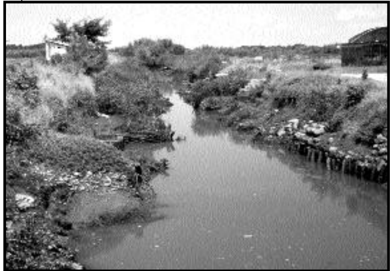
Los canales de drenaje requieren de una buena construcción, estabilización y mantenimiento para evitar la erosión.
