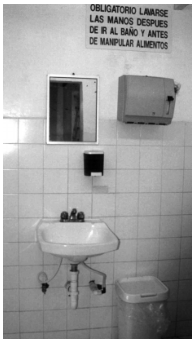
Figura 4.4 Instalaciones para el lavado de manos con jabón, papel secante, bote de basura y secamiento, en el área de baños, son requerimientos mínimos para cumplir con las buenas prácticas de manufactura.
