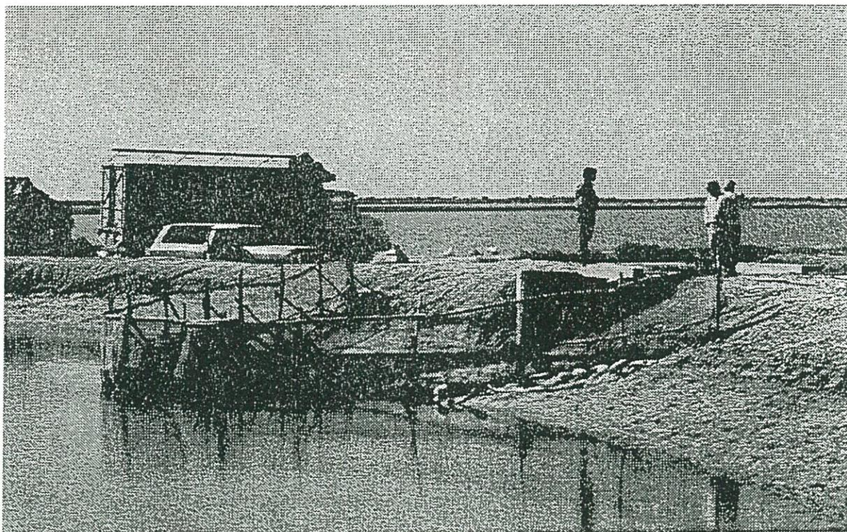
Foto 18. Filtro de cerco en un reservorio, frente a una compuerta de entrada, se utiliza para incrementar la superficie de filtración y retener basura.
