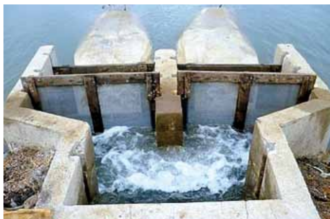
Figura 34. Proceso final de llenado de un estanque en una granja camaronera, donde aún se mantienen los filtros con marco de madera y los de bolso con mallas de ojo fino, para evitar el ingreso de basuras y material biológico no deseable. Foto cortesía del Ing. C. Lara.
