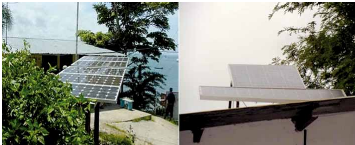
Figura 69. Paneles de energía solar utilizados en una granja camaronera como alternativa para reducir los costos por consumo de electricidad. Foto cortesía del Ing. C. Lara.
