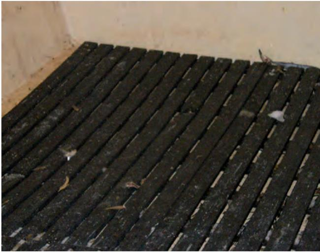
Fig 10. Debe evitarse el uso de material poroso, como la madera, sustituyendo por plástico.
