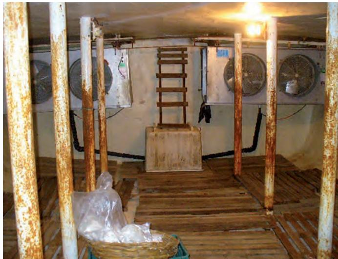
Figura 21. Las superficies deben ser fáciles de limpiar y de materiales que no propicien el desarrollo microbiológico o la contaminación química. Deben eliminarse restos de óxido y dar el mantenimiento periódico que asegure que el equipo no representa un riesgo de contaminación.
