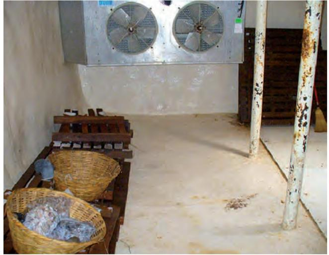
Fig 9. Todas las superficies deben estar protegidas contra la oxidación, por lo que es indispensable el mantenimiento constante.
