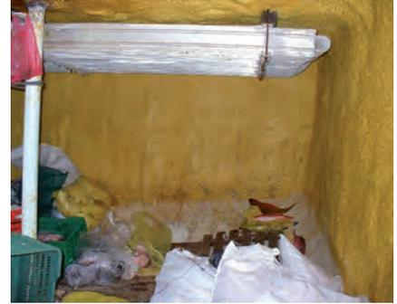
Figura 7. Las bodegas debe contar con un recubrimiento que permita tener superficies lisas y no porosas. Además debe darse mantenimiento constante para garantizar su funcionalidad, evitando un gasto innecesario de energía al mantener las temperaturas requeridas para asegurar la inocuidad del producto.
