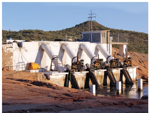
Fig. 24 Cárcamo de bombeo.
