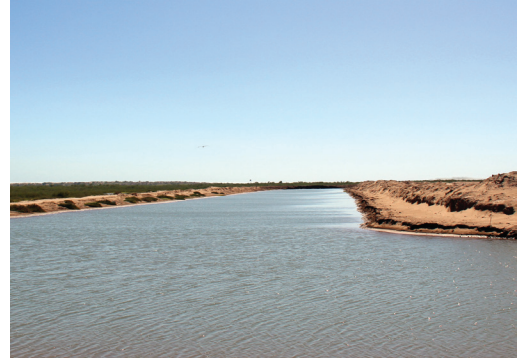
Fig. 22 Canal de llamada.
