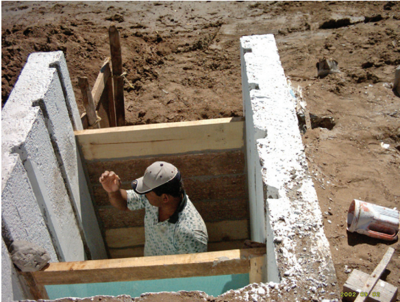
Fig. 17 Mantenimiento de compuertas.
