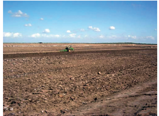
Fig. 34 Nivelación de fondos de los estanques.
