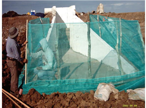
Fig. 18 Instalación de filtros.
