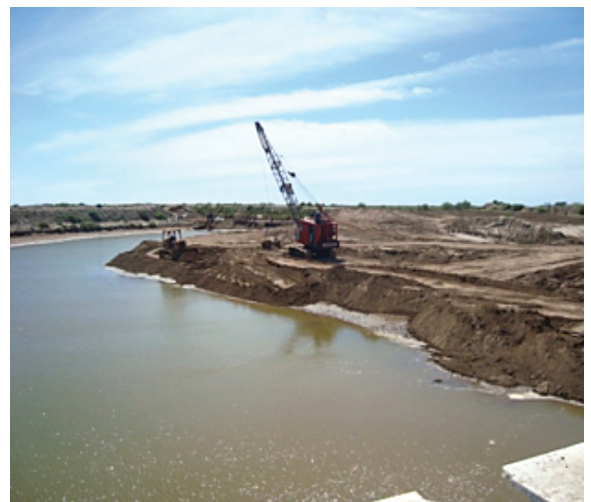
Fig. 19 Dragado de canales.
