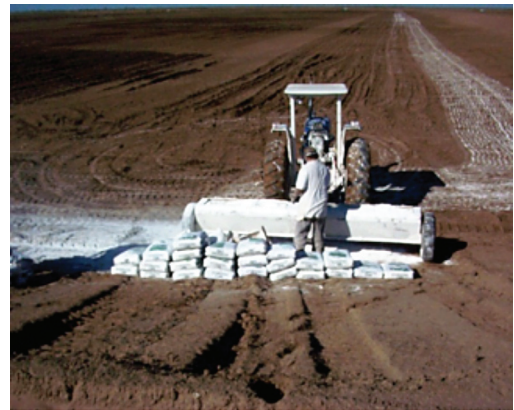
Fig. 32 Encalado de la superficie del fondo del estanque.
