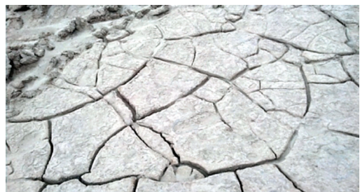
Fig. 33 Fondo del estanque con grietas.
