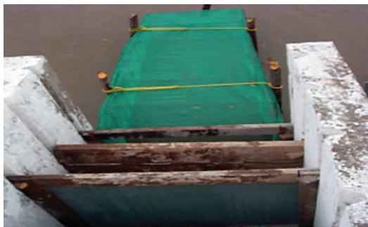
Fig. 30 Bastidores de filtrado.
