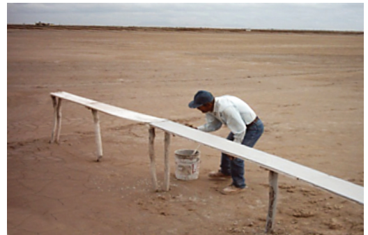
Fig. 35 Mantenimiento de muelles.
