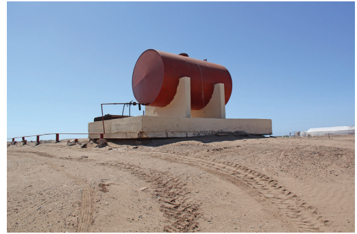
Fig. 25 Depósito de almacenamiento de diesel.
