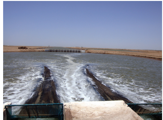
Fig. 26 Mallas para filtro en cárcamo.
